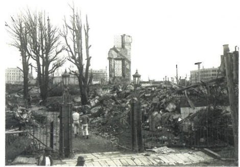
震災によって倒壊した印刷局証券印刷部
