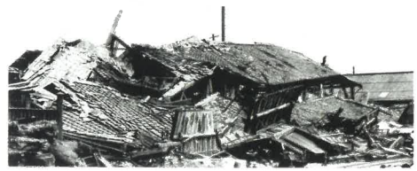
壊滅的な被害を受けた抄紙工場
