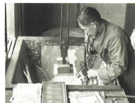
図6 電胎法 化学的な手法で原版から反転型をとることをくり返し、複製版をつくる方法
