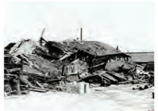
関東大震災によって倒壊した王子の抄紙工場
