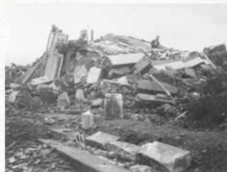
図12 がれきの山となった工場
