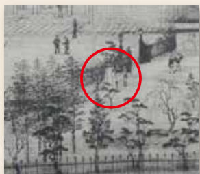
④工場通用門
