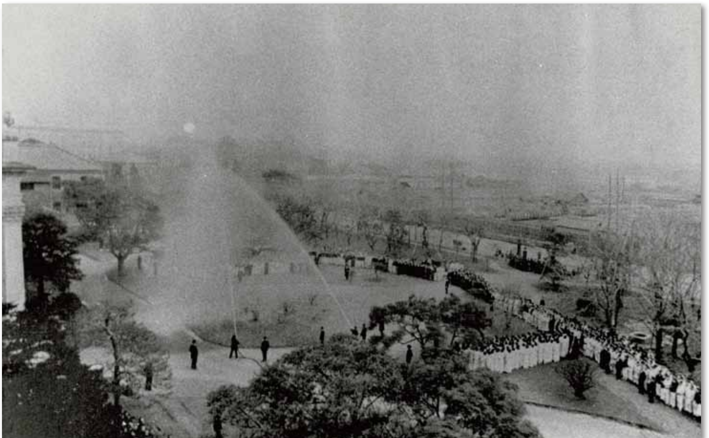
(参考) 東京大手町にあった工場前庭で行われた非常訓練 明治36(1903)年頃 職員の衆目のなか放水実演が行われている。 なお、明治32年に設置された消火栓から取水したと思われる。
