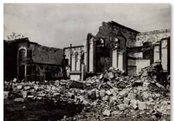
図5 関東大震災に伴う火災によって損壊・焼失した工場
