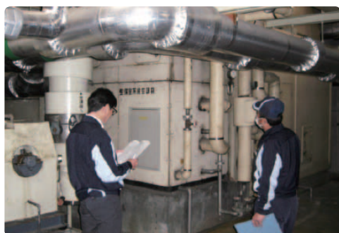
点検活動の様子(東京工場)
