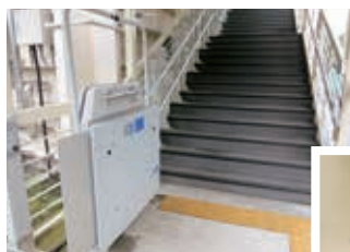
←車いす用昇降機
