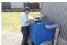
雨水タンク内の清掃
