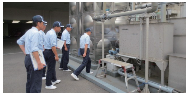
環境保全施設点検
