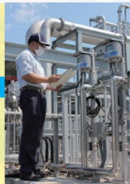
製紙工程において特に排水異常となりやすい測定項目である浮遊物質質量 (SS) と水素イオン濃度 (pH) の水質測定を行い、「下水道法」や「小田原市下水道条例」等で定められた排水基準値内であれば、公共下水道に放流する仕組みとなっています。もし基準値を超過している場合には、基準値内になるまで再度、新排水処理設備で調整され、調整後に下水道に放流されます。
