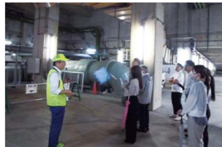
下水処理施設の見学 (王子工場)
