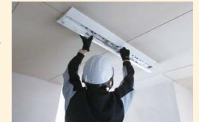
LED照明更新の様子 (岡山工場)
