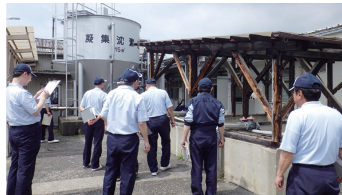
環境保全施設の点検（彦根工場）
